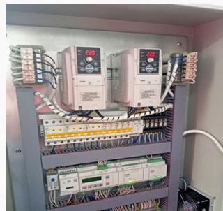
установка по очистке воды в д.Назимово
